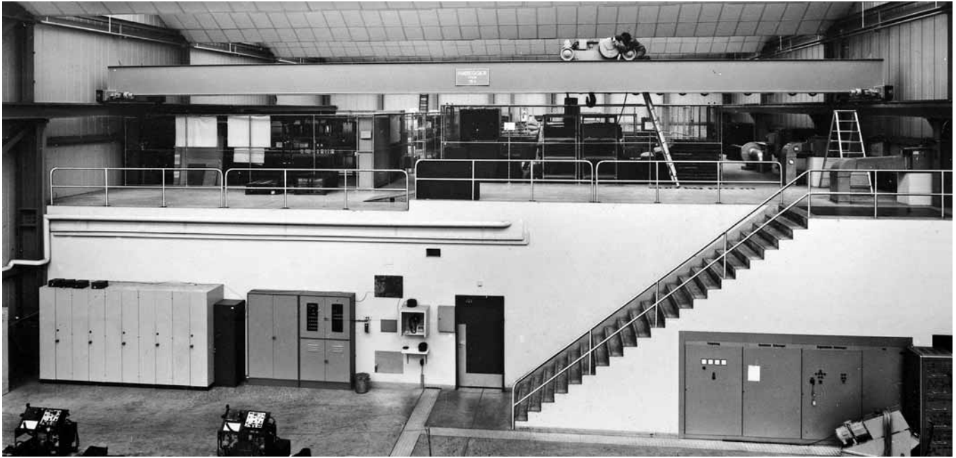
Bild 15: Zweitträgerkran, der von einer grossen Bühne aus unter Verwendung von Leitern mit Einhakvorrichtung und Bockleitern gewartet werden kann.
