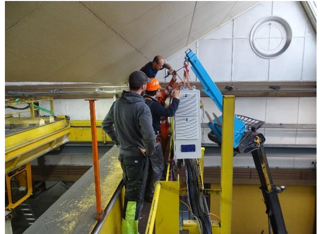
Montage des neuen Schrankes
