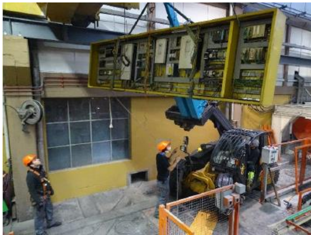
Rückbau Schaltschrank mit Manitu
