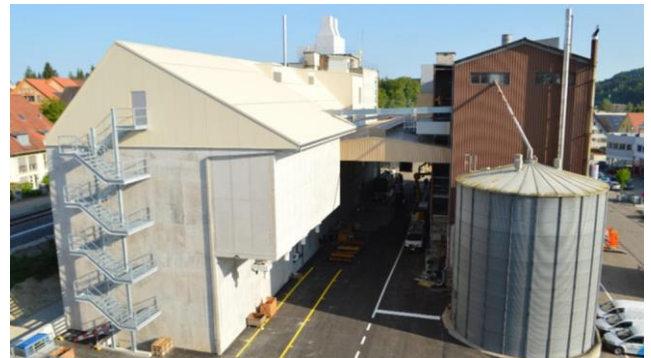
Bild (v.l.n.r): Silo 2 & Silo 1 / 104
