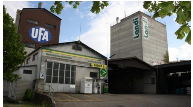
Bild (v.l.n.r): Silo 1 & Betonsilo
